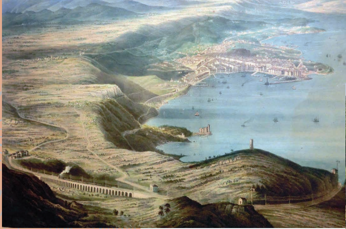
Železniška proga se preko Kruškega roba spušča proti Trstu. Viadukt iz kraskega kamna je iz bližnjih kamolomov, Nabrežine in Repentabora.
